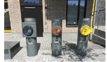
Inkassen till sopsugsanläggningen. Anläggningen ska bidra till minskade transporter i området.
